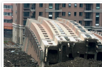
上海莲花河畔景观苑楼房 倒塌事故
